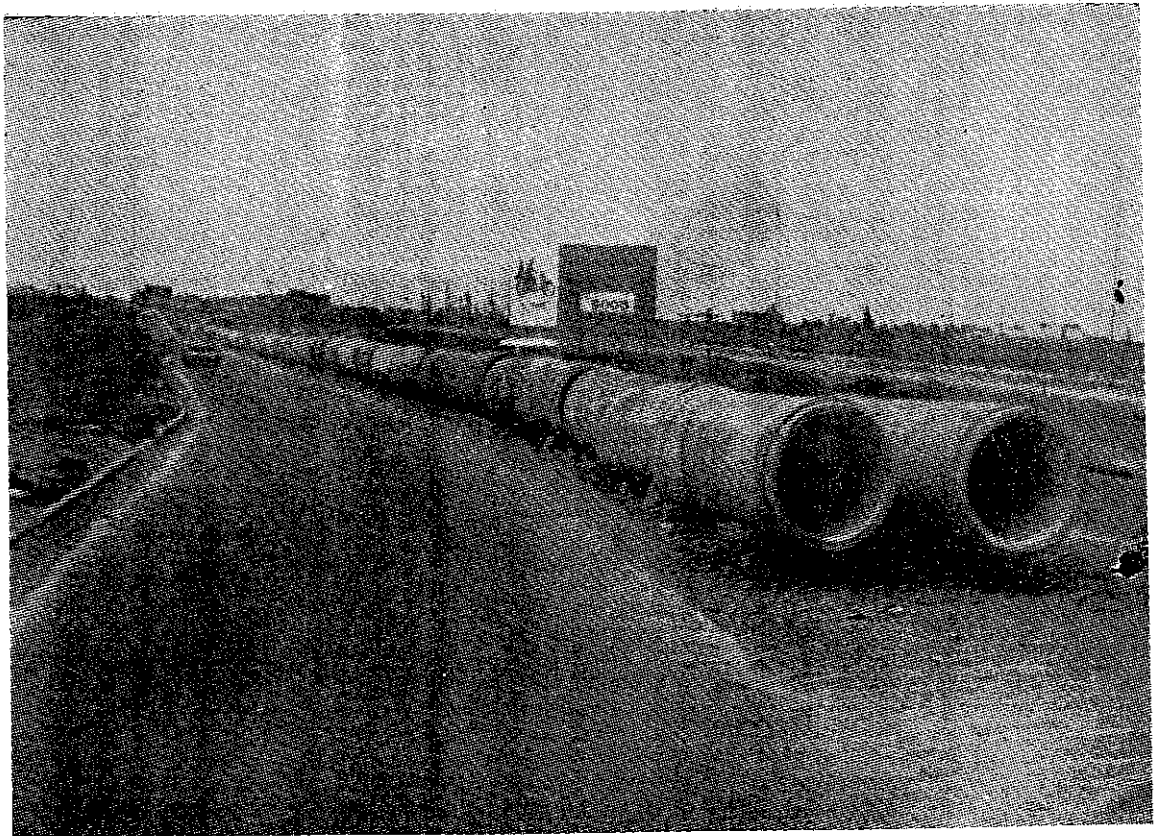
Tubería para el Colector Surco, en el sector de la Prolongación Avda. Javier Prado, Lima.
