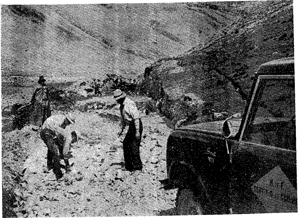
Obreros trabajando en la construcción de la vía Tayabamba - Huancaspata. Km. 22.
