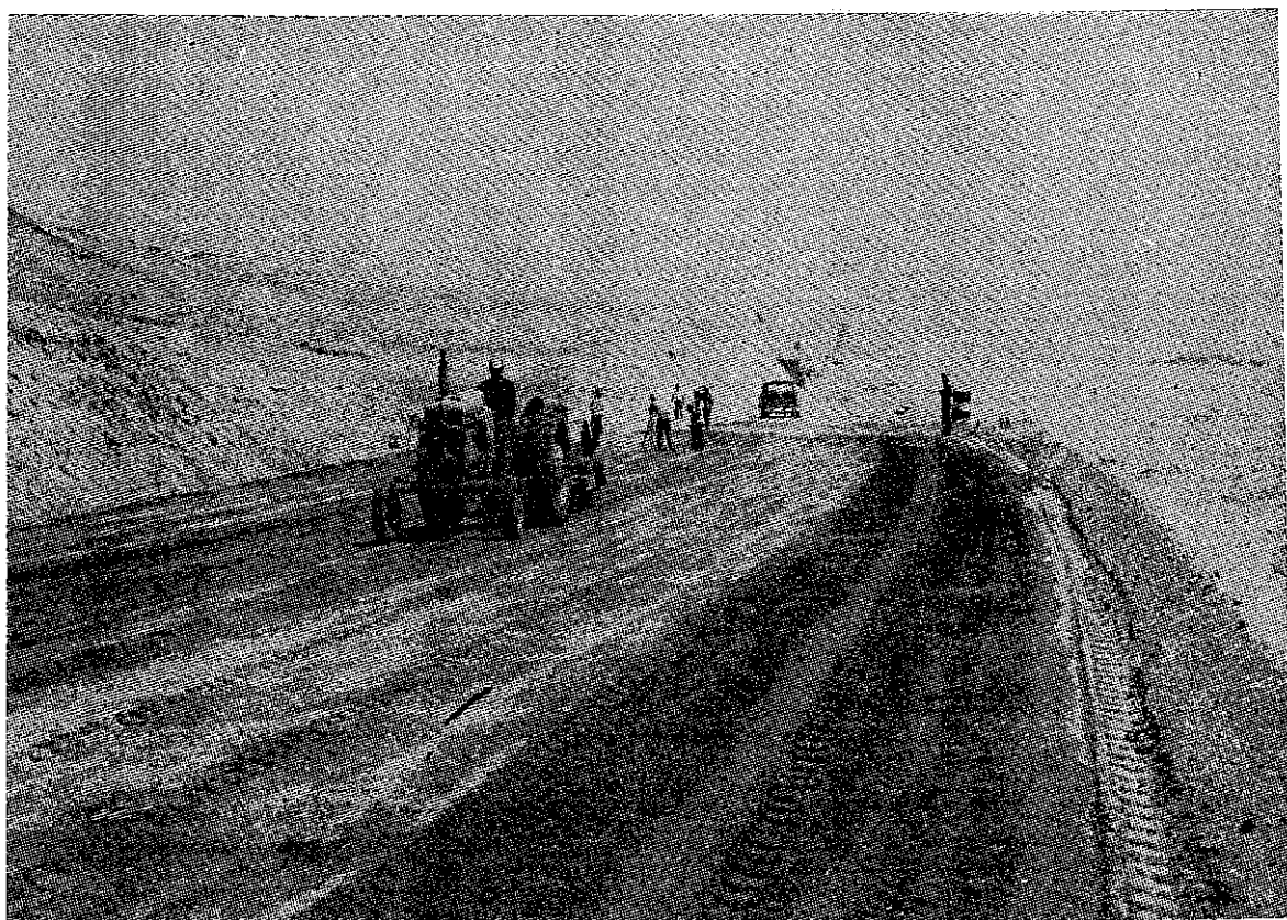
Otro aspecto de la labor de compactación
