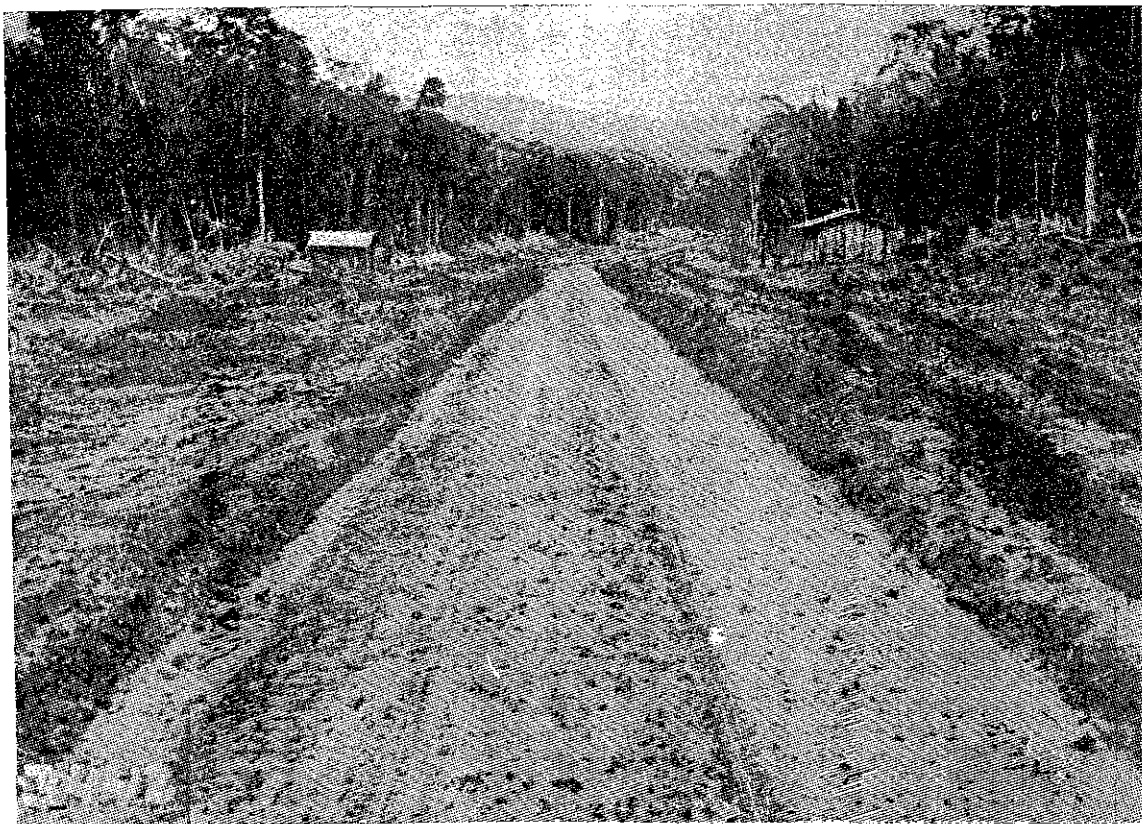
Explanación, con extenso roce, en el Km. 14.
