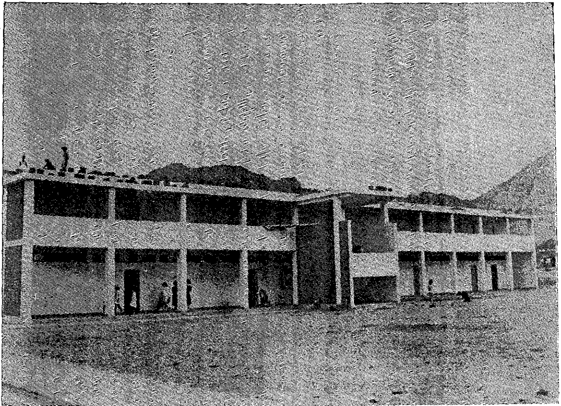
Moderna escuela primaria, construida dentro del Plan Nacional de Construcciones Escolares.
