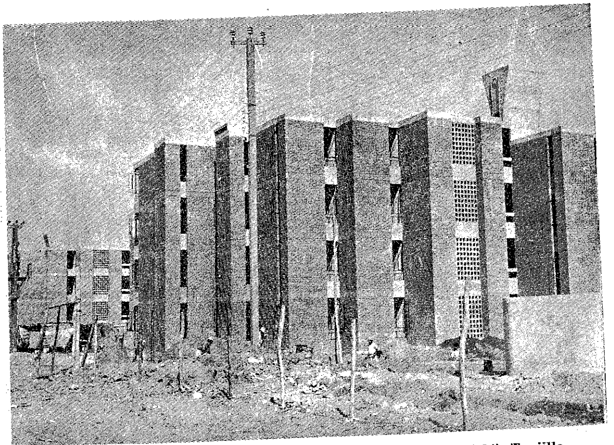
Construcción de viviendas en la Urbanización "Luis Albretch", Trujillo
