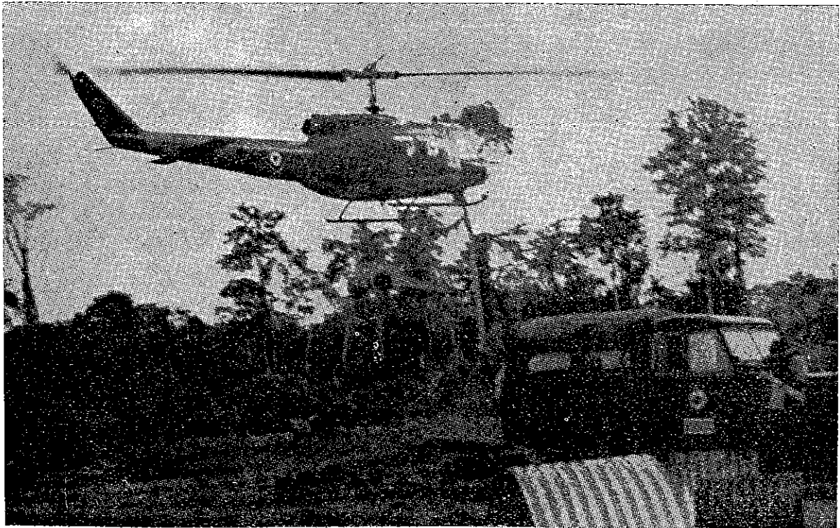
HELICOPTERO BELL HU-1A transportando maquinaria pesada para la construcción de los campos de aterrizaje en la Selva.
