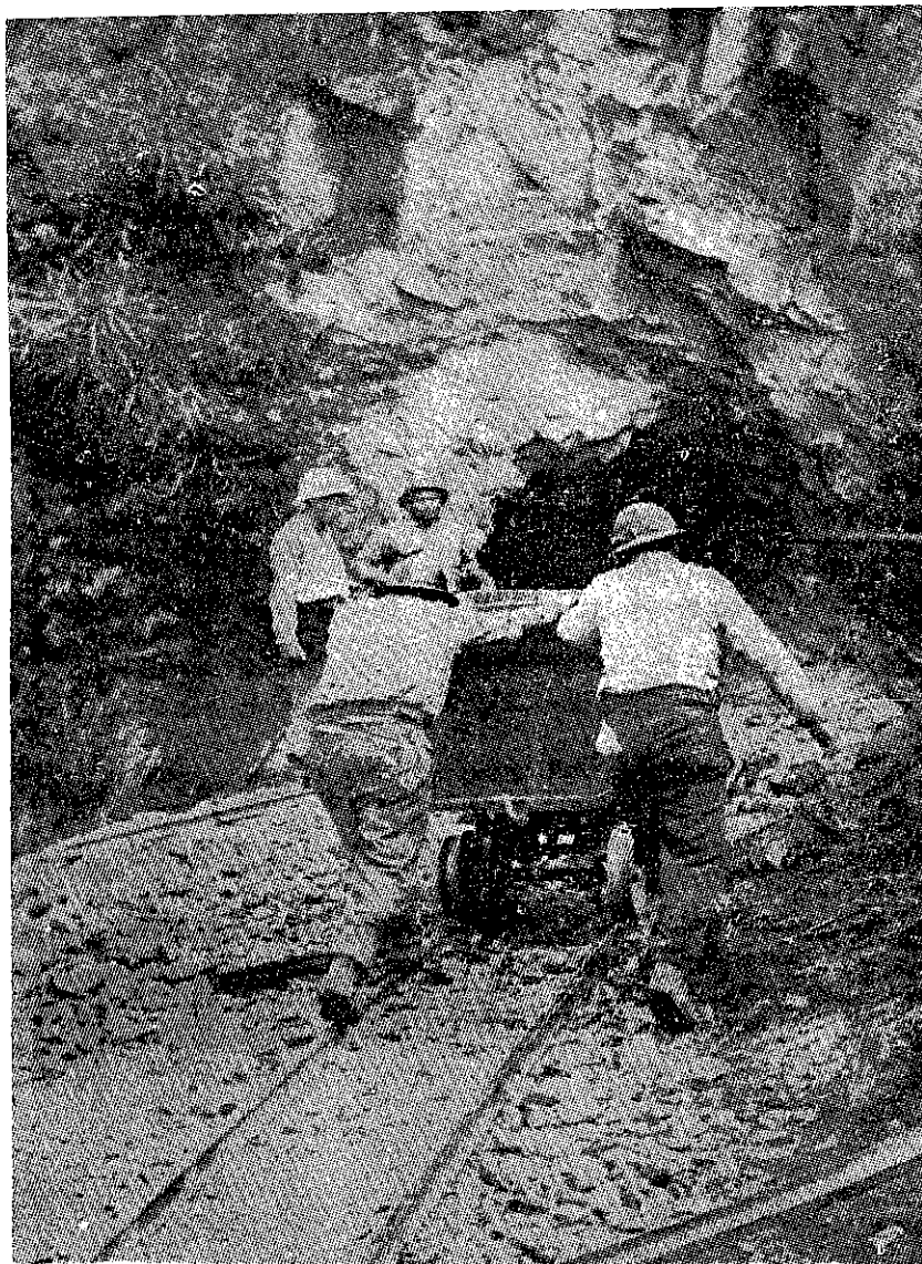
Perforación del túnel N° 3 para la irrigación de Lircay. Huancavelica
