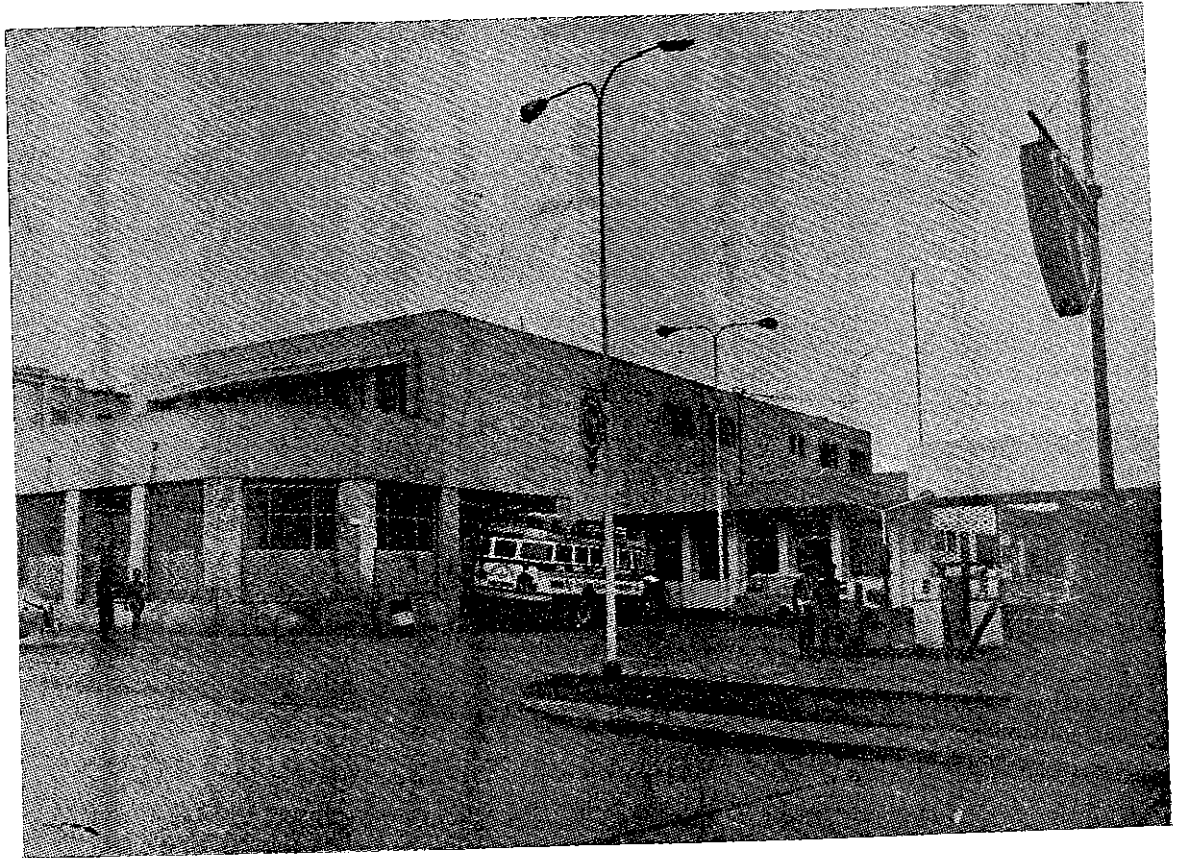
Fachada del local expropiado para la 30ª Comandancia (Tránsito)
