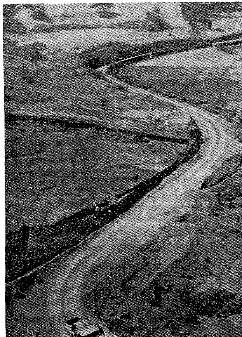
Carretera Tres Cruces-La Pampa-Corongo. Ancash
