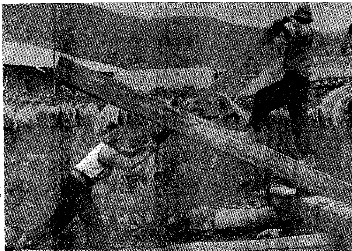
Comuneros preparando tijerales para el techado de una escuela en Uripa-Andahuaylas.
