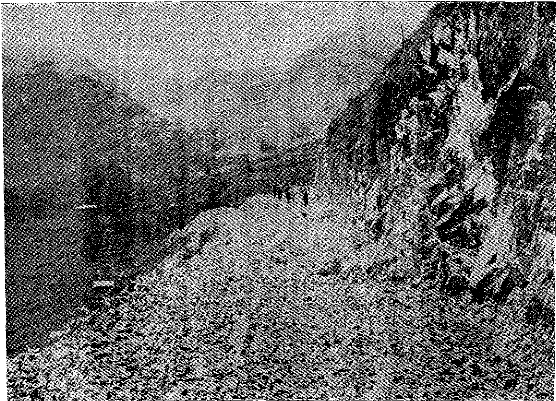
Sector rocoso en el Km. 47.7 de la carretera Cahua - Pamplona - Cajatambo.
