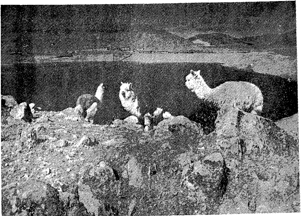
A 4,500 Mts. de altitud, la Represa de "Pañe" con capacidad para 85 millones de metros cúbicos de agua.
