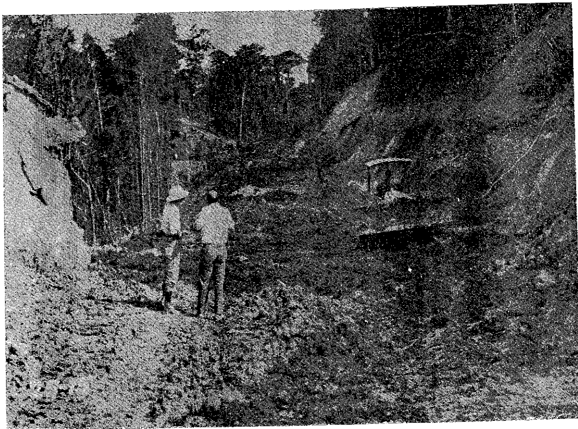
Corte cerrado en pleno trabajo. Km.10.
