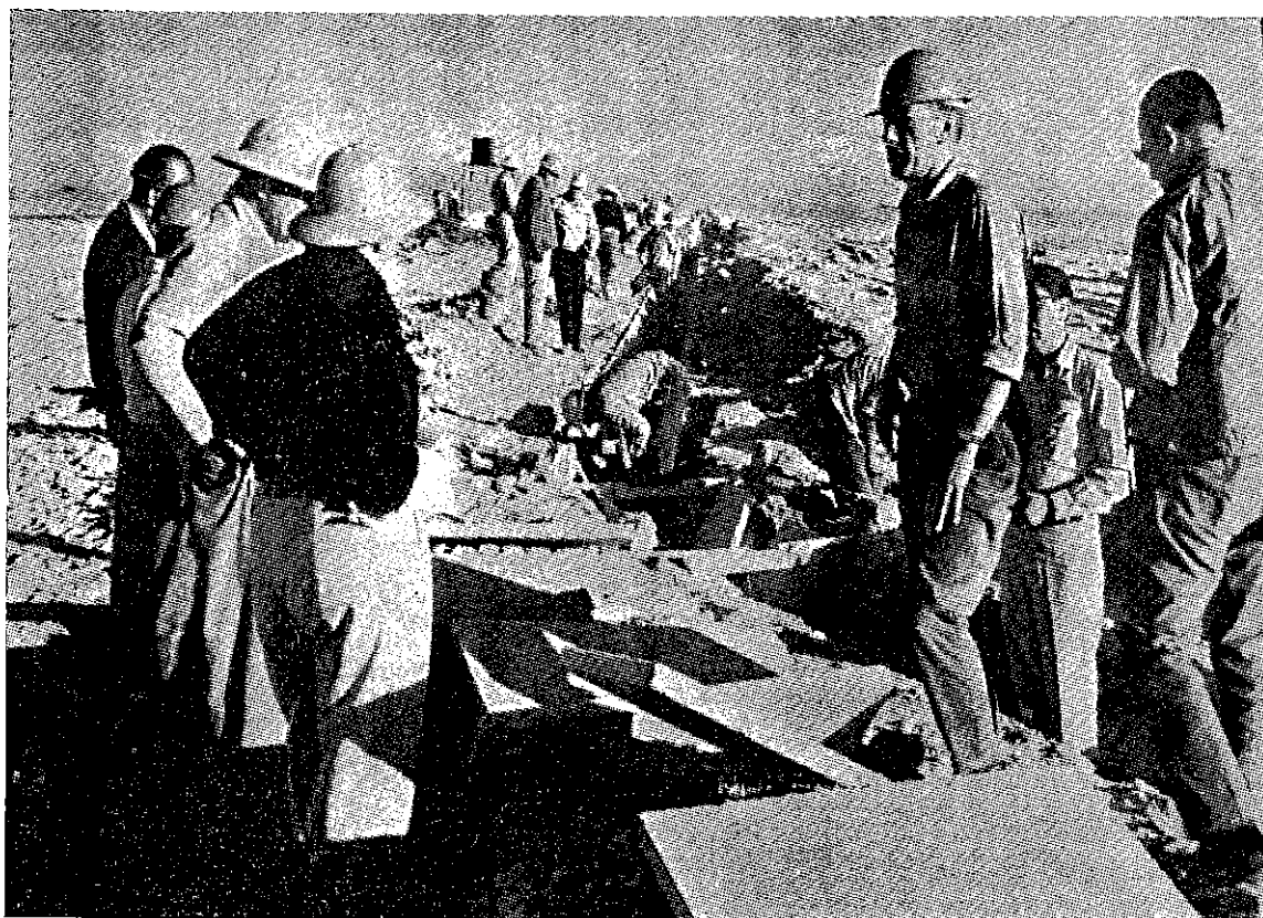
Construcción de sub - laterales.
