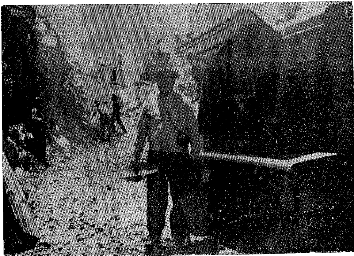
Corte en roca en la carretera "Pativilca - Choque Congas" en Ancash.
