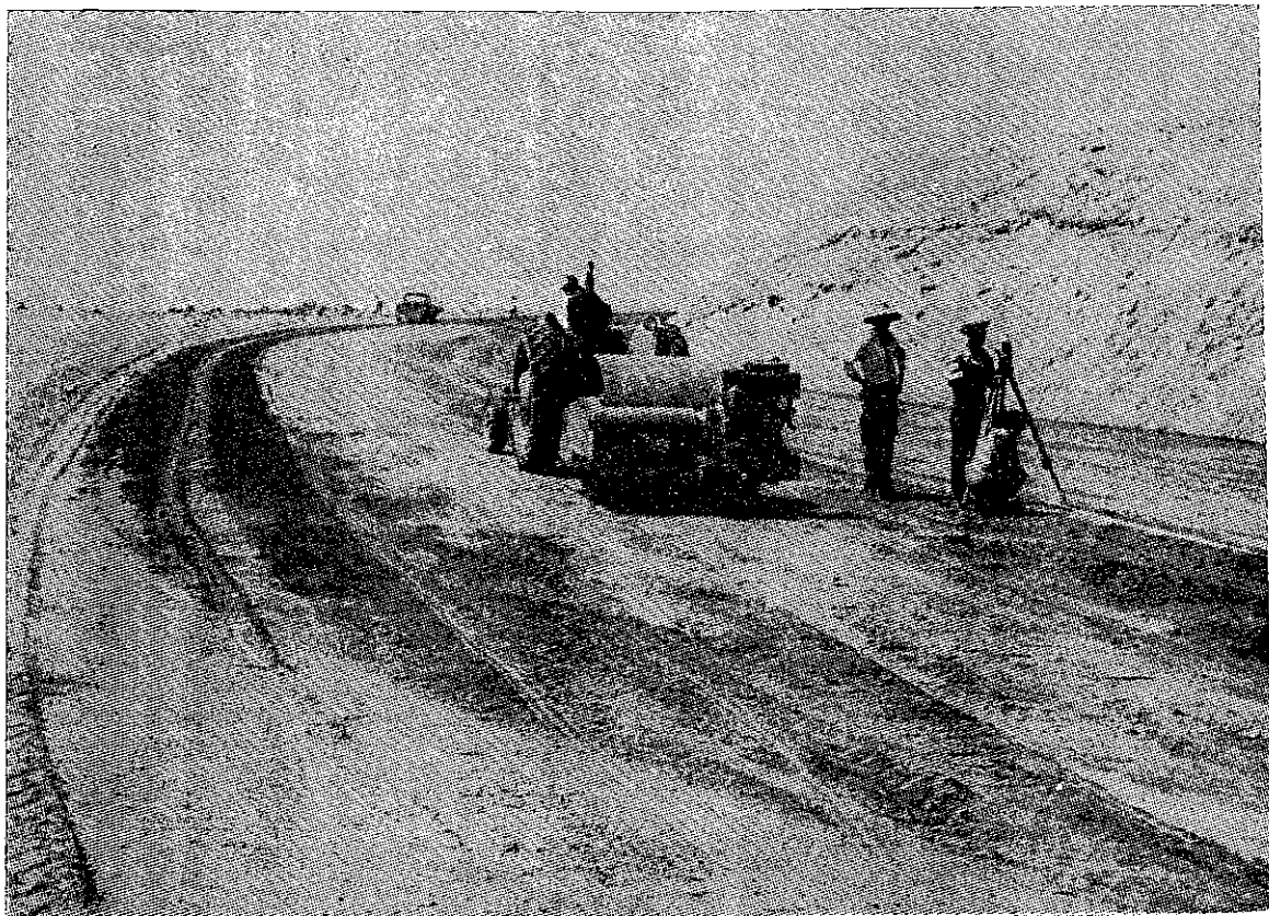
Rodillo vibratorio usado para obtener mejor compactación en el Km. 10,000
