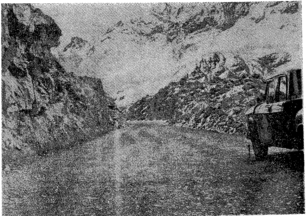
Imponente corte cerrado en la construcción de la Variante "Ticlio".
