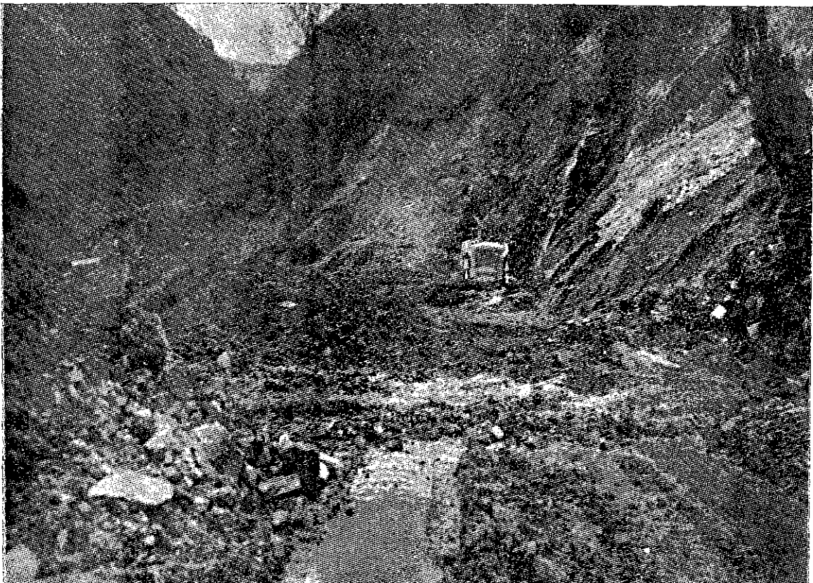
Trabajos en la carretera de acceso a Pomabamba. Ancash
