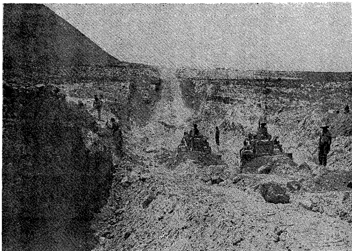
Tractores trabajando en el Km. 10.200.
