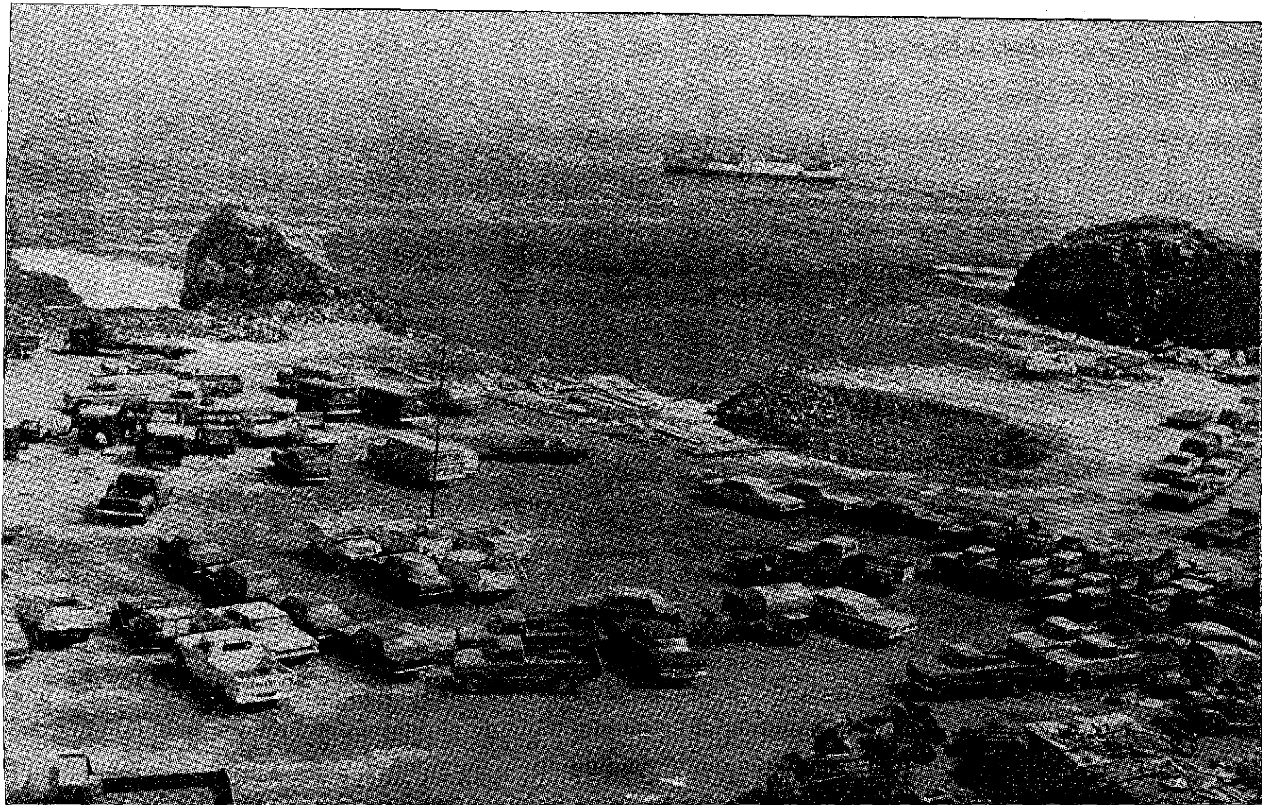
Relleno de la Bahía Sorda, en Matarani, ganada al mar para carga rodante
