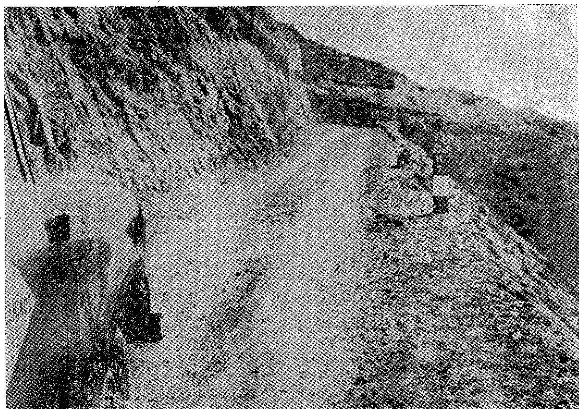
Explanación de la carretera.
