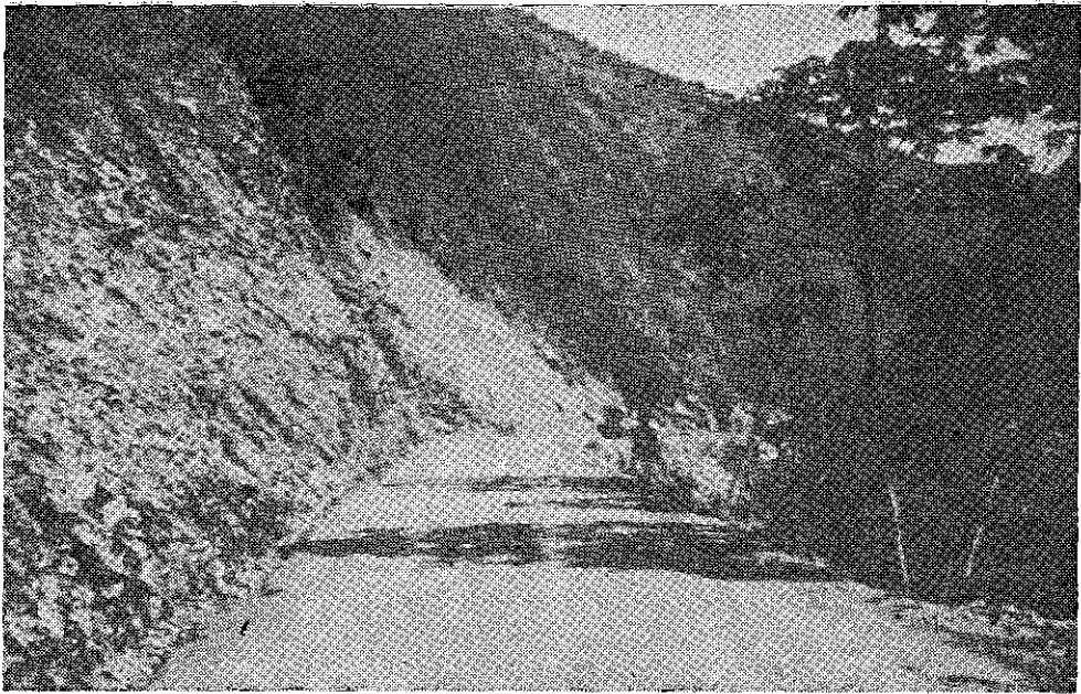
Tramo correspondiente al kilómetro 96 de la carretera Ollantaytambo-Umasbamba.
