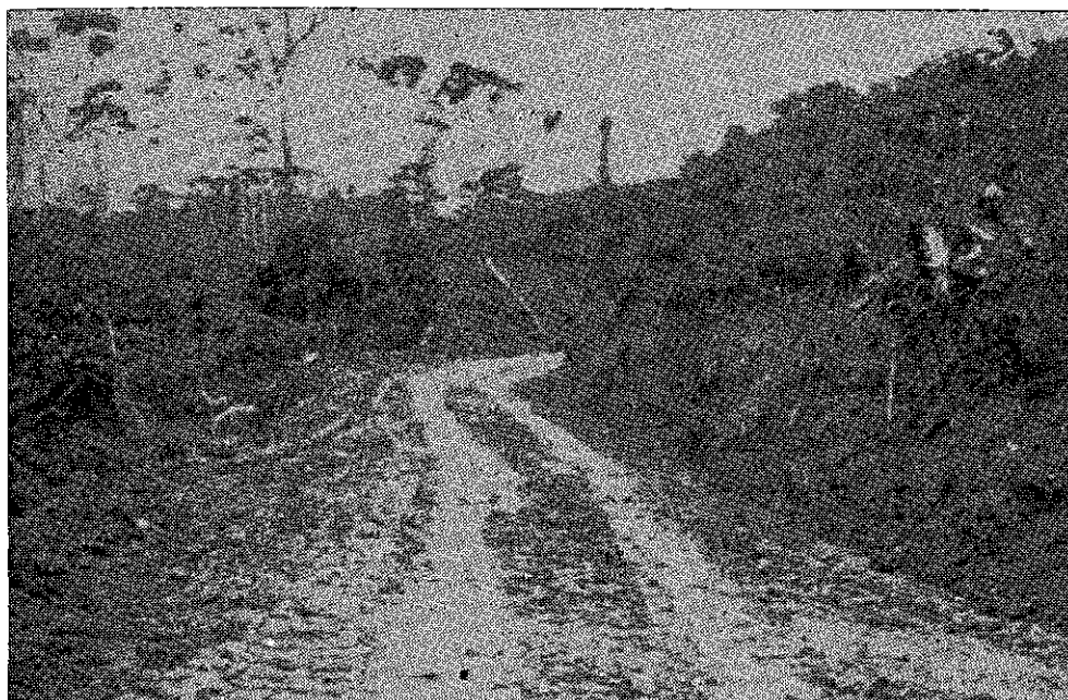
Trabajos de explanación del camino principal que enlaza la colonia de Nueva Nazareth con la carretera Olmos-Río Marañón.
