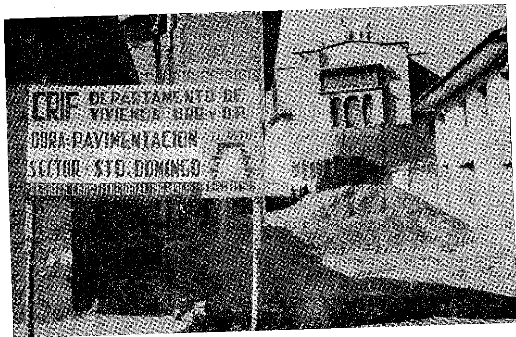
Obras de pavimentación en el sector Santo Domingo.
