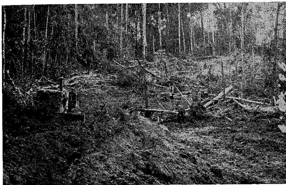
Carretera Atalaya - Itahuanía - Manú.Trabajo de Rocce. Kmt.243.
