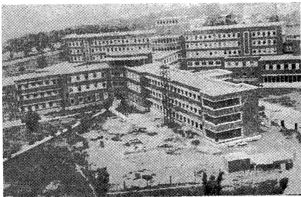
Ampliación del Centro Médico Naval con la construcción del edificio Nº 5.
