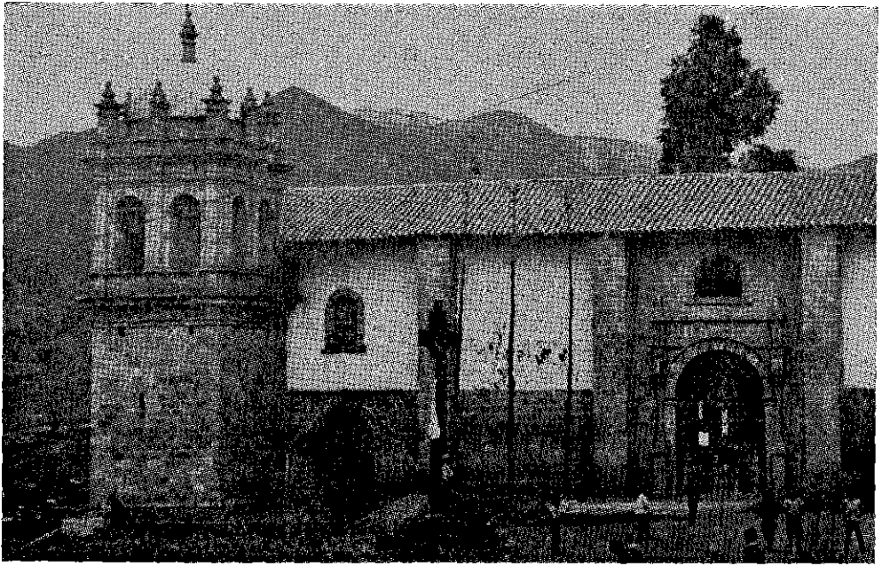
Proceso de Reconstrucción del Templo de San Cristóbal en el Barrio Arqueológico de Colescampata.— Cuzco.
