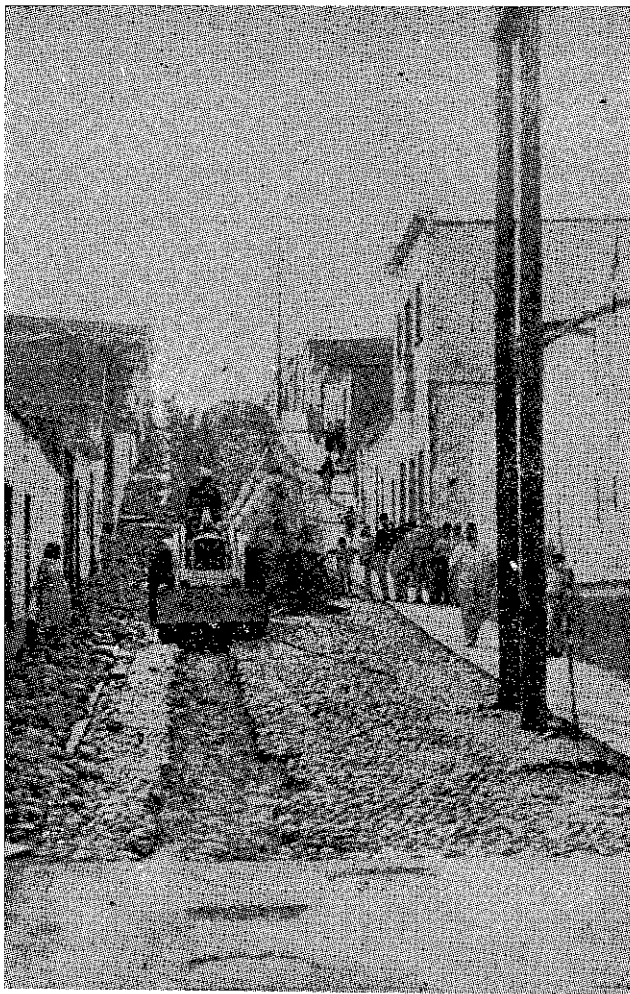
Excavación de zanjas para tendido de tubería de Agua Potable.— PACASMAYO.
