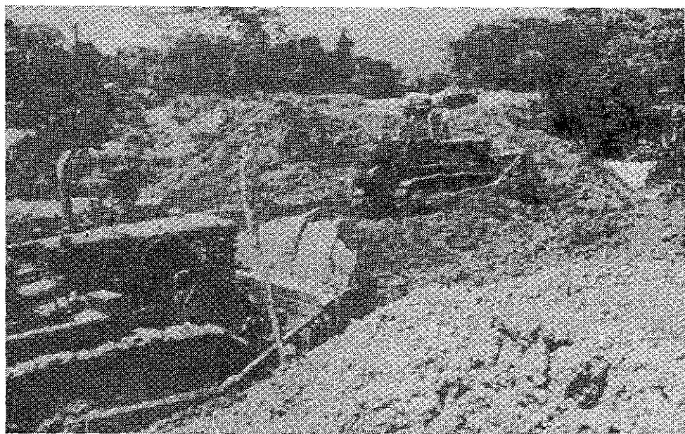
CARRETERA SATIPO-MAZAMARI-PUERTO RICO. — Trabajos de explanación en el Km. 18.
