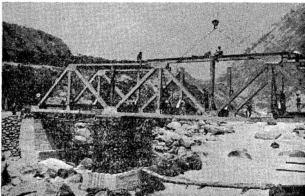
Montando un puente sobre el río Vilcanota. Prolongación F. C. Cuzco - Santa Ana Km. 134.
