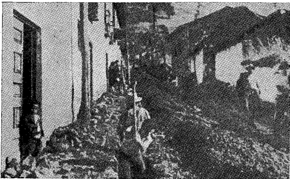
Colaboración de la Comunidad en la apertura de zanjas en la red de distribución San Pedro de Cachora - Apurímac.
