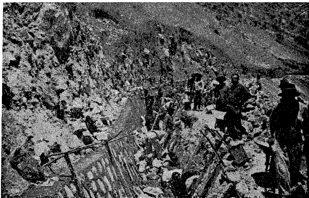
Irrigación de Chuyas - Huaychao. Trabajando en el revestimiento de canales.
