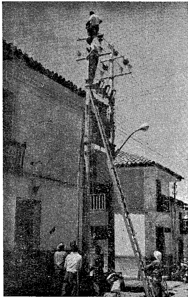
Montaje de la Subestación de 75 K. V. A. en la ciudad de San Jerónimo - Junín.
