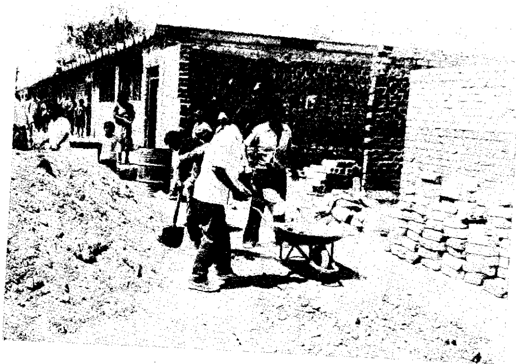
El Ministro observa (arriba) un techo destruido en el Rímac. En Villa El Salvador (abajo) los padres de familia construyen aulas.
