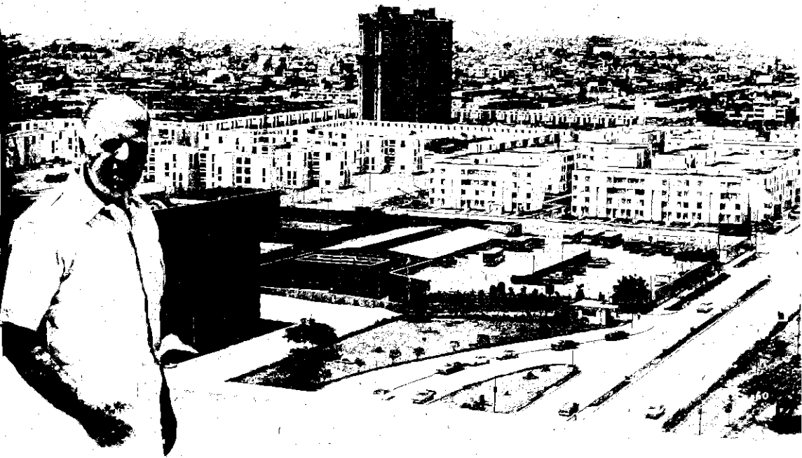
El Presidente Belaunde ante una impresionante vista panorámica de las Torres de San Borja. Abajo: Inspección de obras de ampliación de la planta de agua potable de Lima, La Atarjea.
