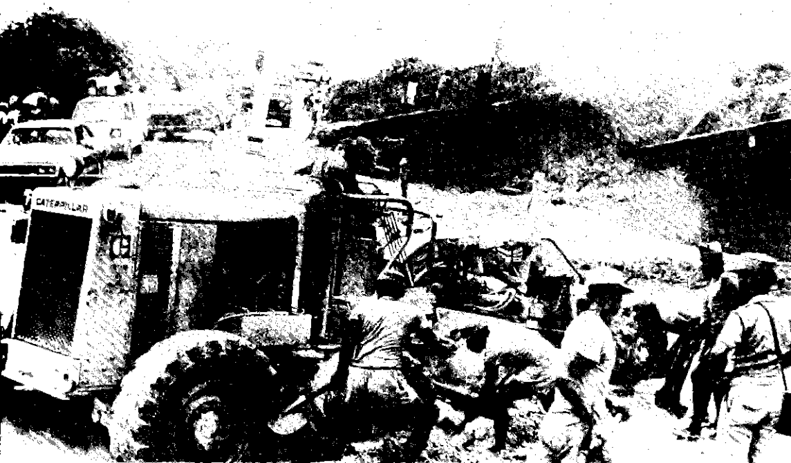
Personal del Ejército habilitando la carretera cerca a Tumbes, afectada durante el periodo de lluvias e inundaciones en el norte.
