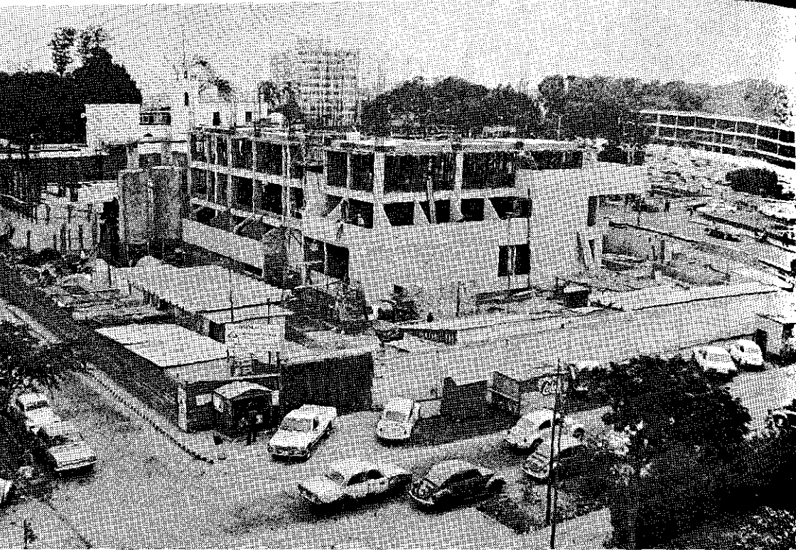
Local en construcción de la Oficina Nacional de los Registros Públicos, ubicado en el distrito de Jesús María, en Lima.
