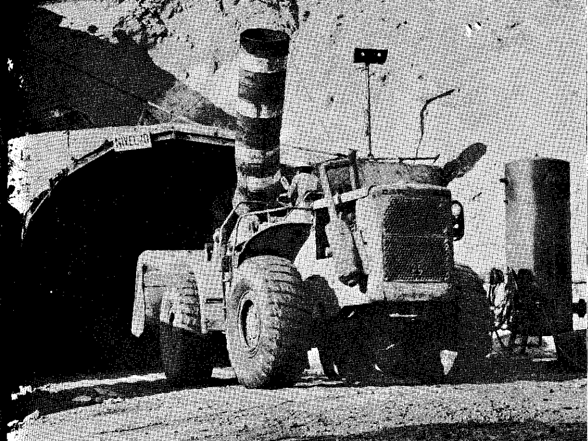
Moderno equipo pesado ingresando al nivel 70, en la bocatomina de la mina Cobriza que opera Centromin Perú.
