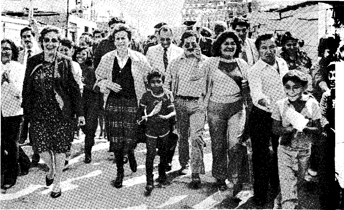
La esposa del Presidente de la República recorriendo el pueblo joven Santa Rosa de Carrillo de Albornoz, en el Callao, donde inauguró obras de saneamiento: agua potable y desagüe.
