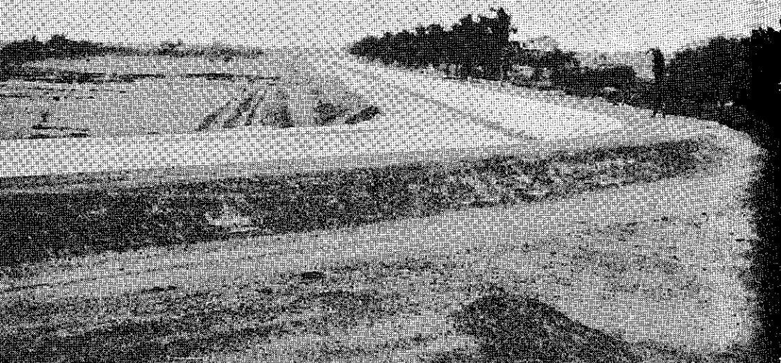
Vista panorámica del canal principal revestido a la altura de la zona de Mocara en el Bajo Piura.
