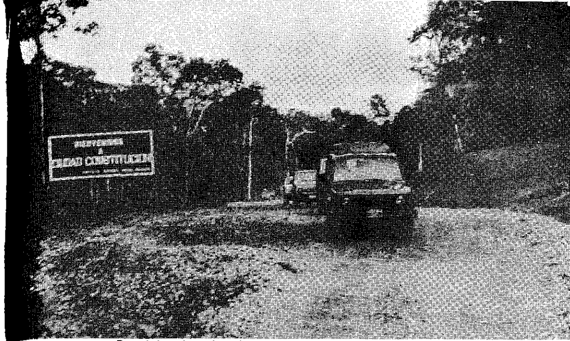
Ramal de enlace al núcleo generador básico de Ciudad Constitución. Es una vía de 750 mts. a partir de la carretera Marginal de la Selva.
