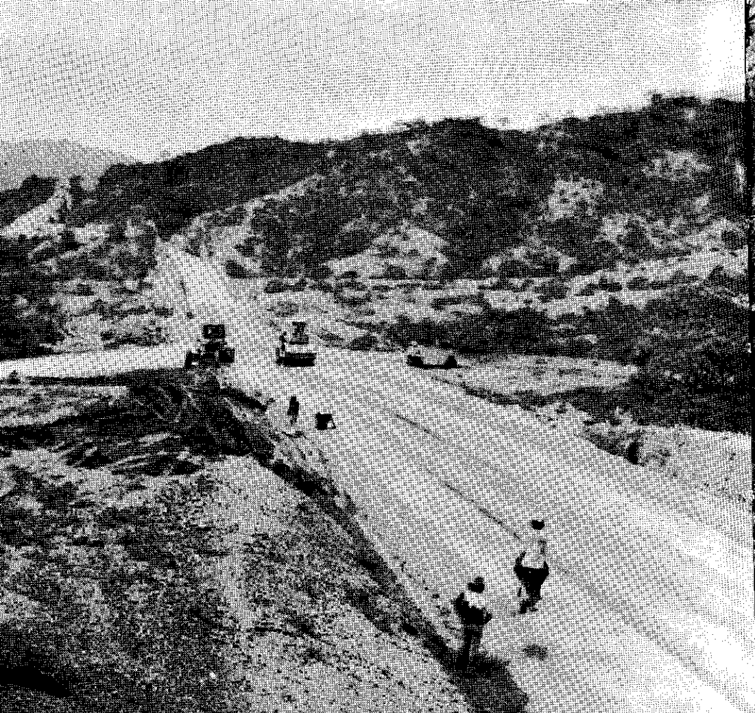
Trabajos de afirmado en la carretera Olmos - Corral Quemado.
