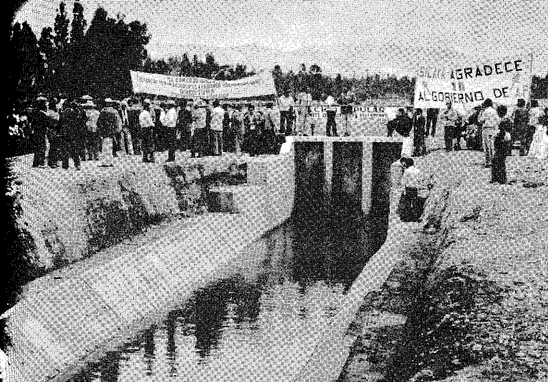
Perspectiva del canal de irrigación de Sicaya, en Huancayo, con motivo de la inauguración de la obra realizada por CORDE-Junín.
