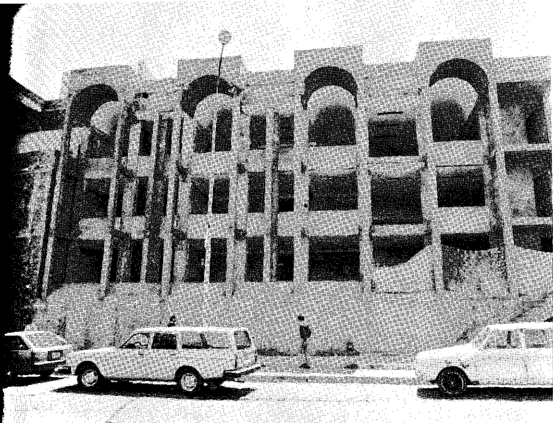
Edificación del Palacio de Justicia de Arequipa.
