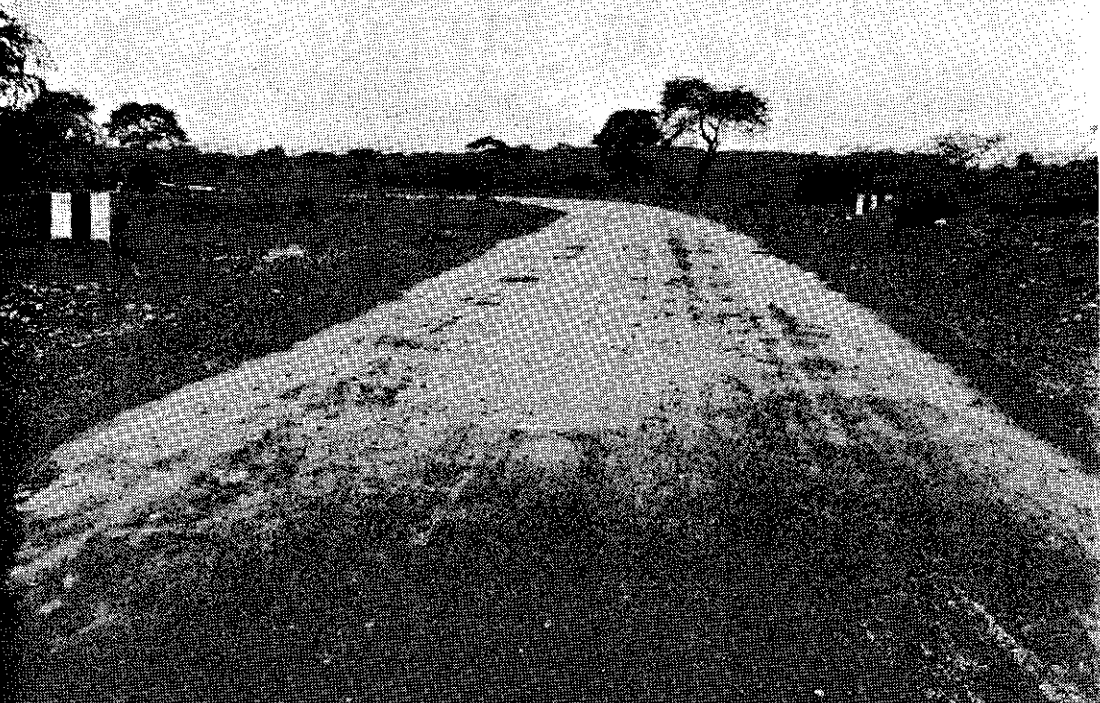
Construcción de la nueva carretera Carrasquillo-Buenos Aires, en Morropón.
