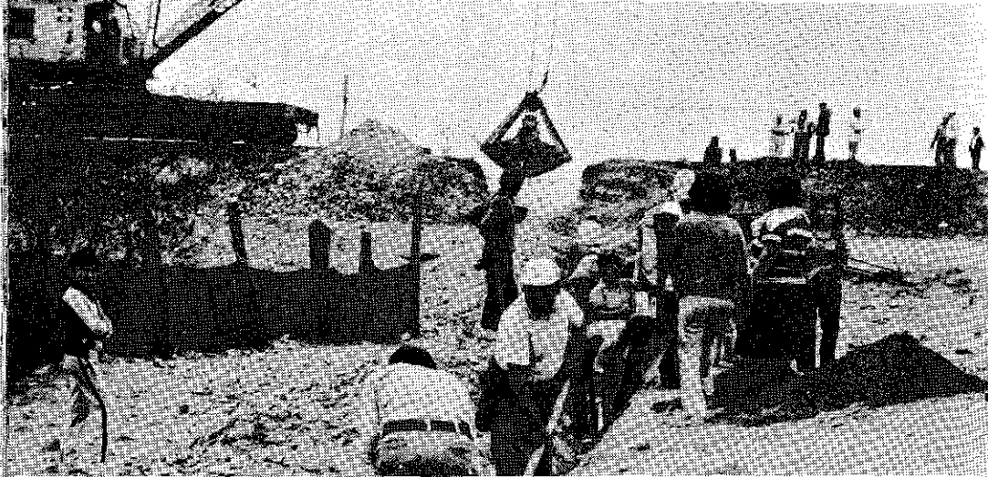
Instalación de red de agua potable en el pueblo joven San Gerónimo en beneficio de 70 familias.
