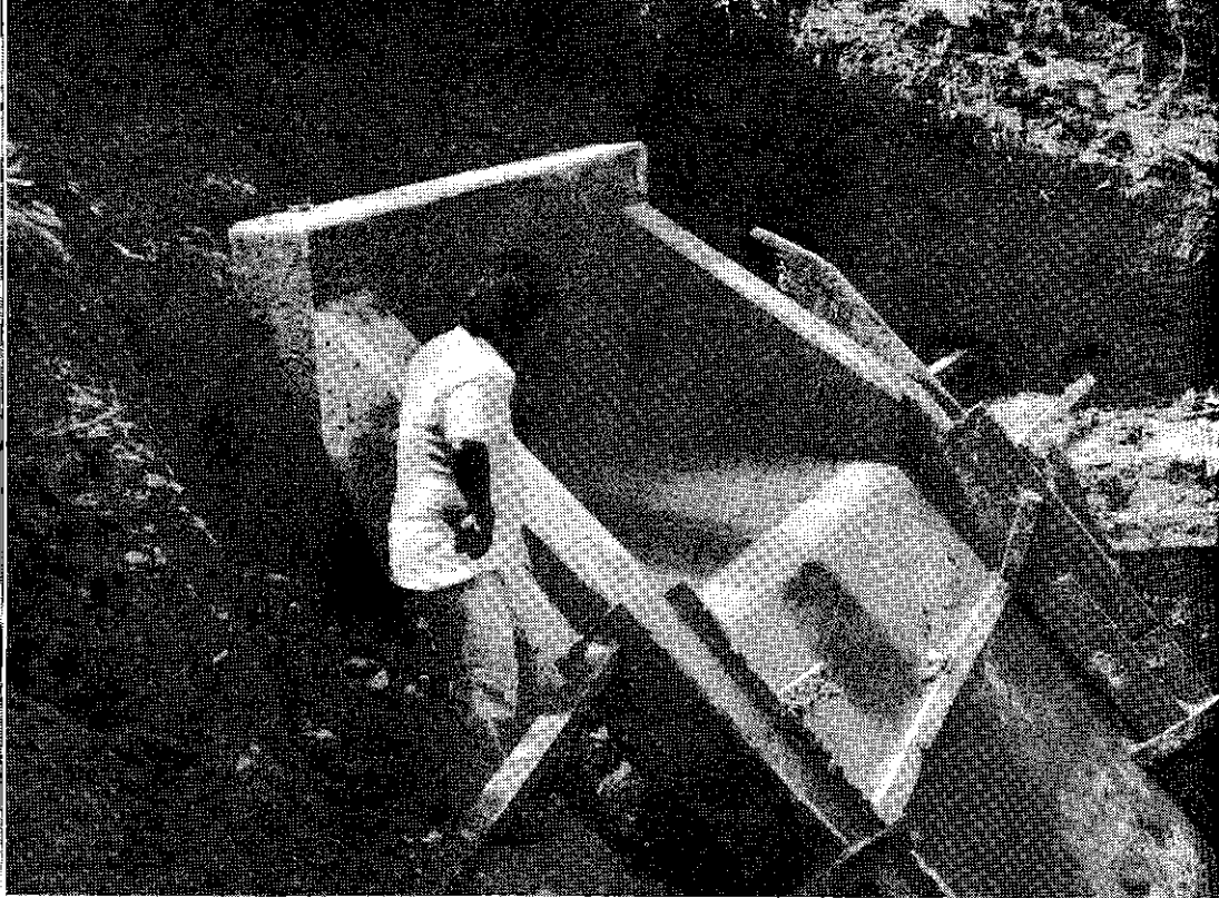
Cabezal de concreto para el drenaje de aguas pluviales (Km. 65) de la carretera "Federico Basadre", Pucallpa-Ucayali. Abajo: Descarga de material a la altura del Km. 74 de la misma vía.
