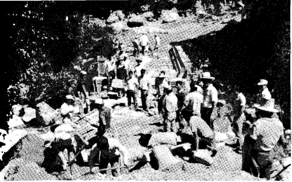
Construcción del puente Pachapiriana, en el distrito de Chontalí, provincia de Jaén.
