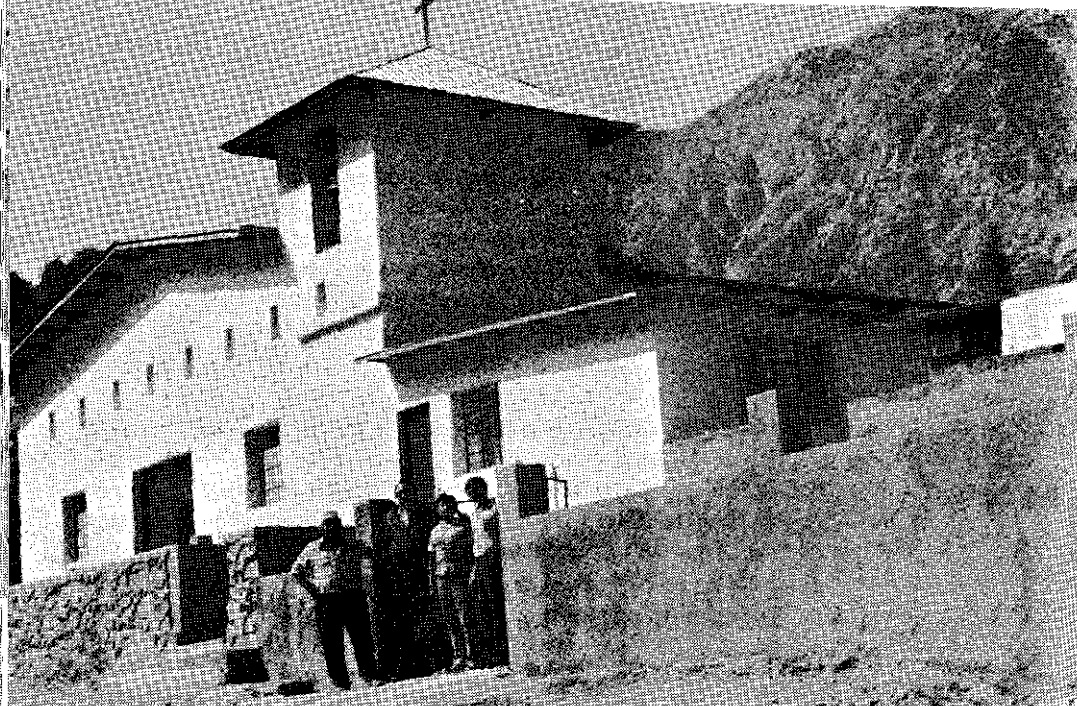
Construcción del local destinado a promotores campesinos en Catahuasi, Yauyos.
