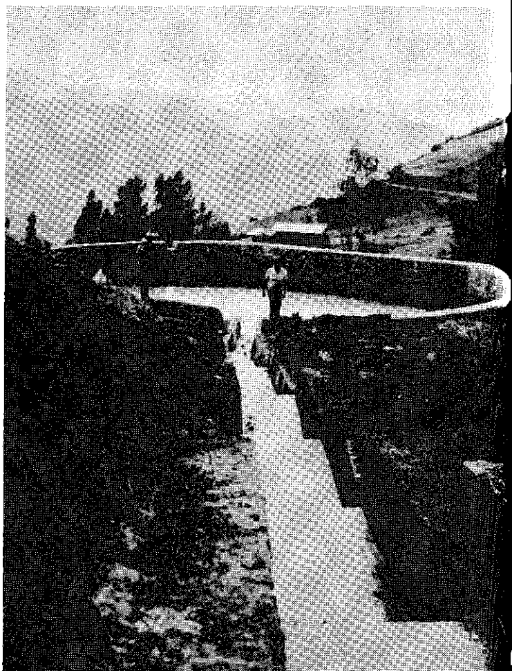
Reservorio de Carrapalday Chico, Otuzco, correspondiente al conjunto de 22 proyectos de infraestructura menor de riego.
