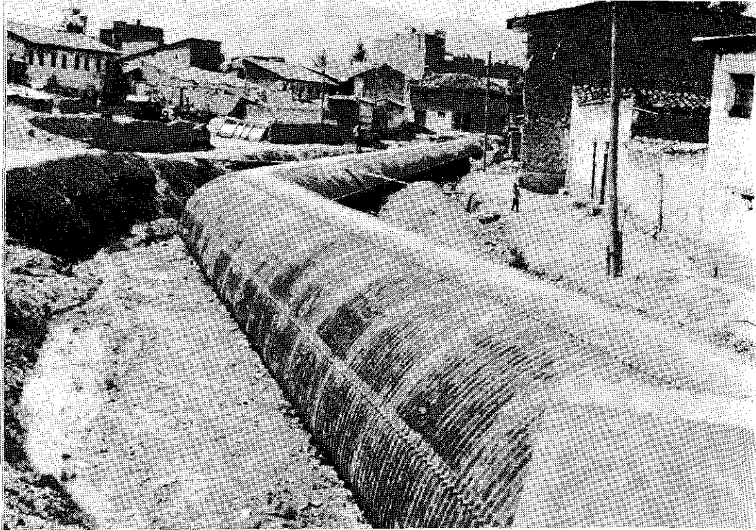
Obra terminada: canalización del río Chilca.
