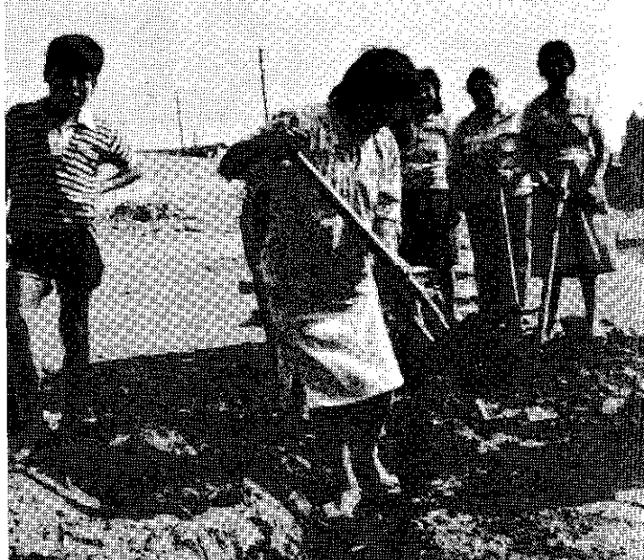
Un grupo de madres de familia trabajando en la instalación de redes de agua potable, en el pueblo joven Ciudad de Dios, Chimbote.
