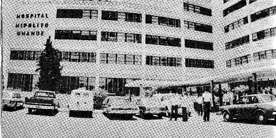
Hospital "Hipólito Unanue" de Tacna.
