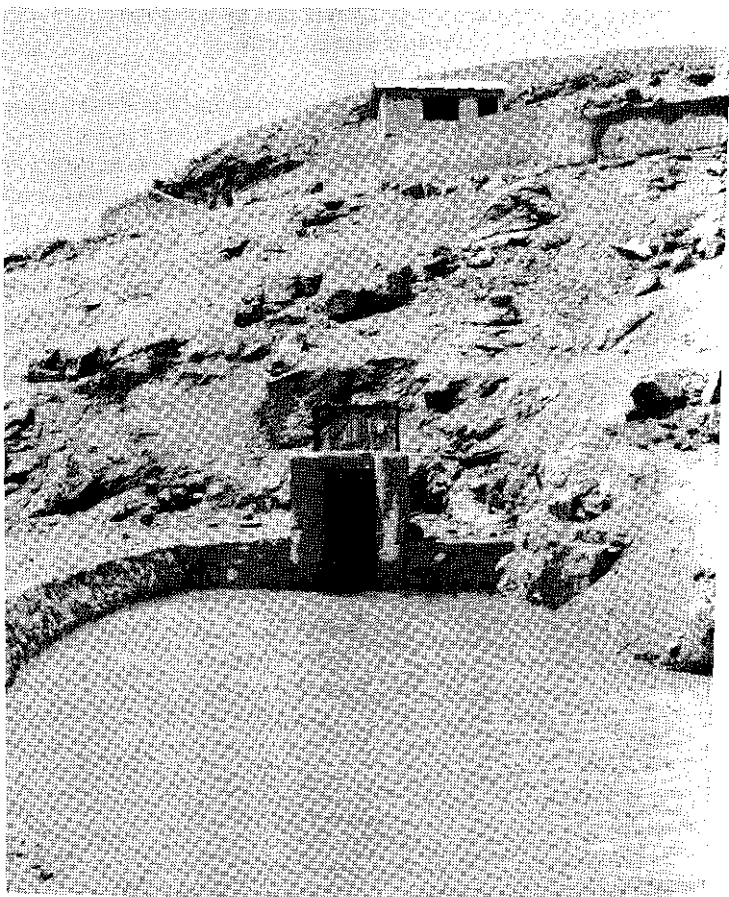
Compuerta del túnel de derivación de la represa Sarumas.
