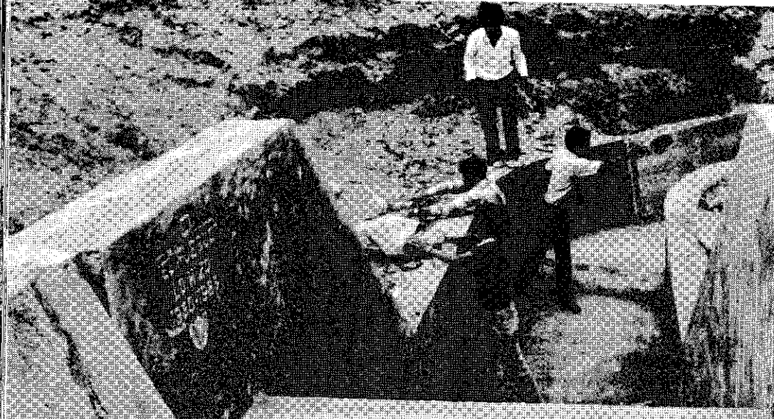
Canal Collique Popán, Zaña. Permitirá ampliar la frontera agrícola en 4 mil hectáreas, a través de un recorrido de 14 Kms. Comprende trabajos de alcantariado, caídas, partidores y caminos de vigilancia.
