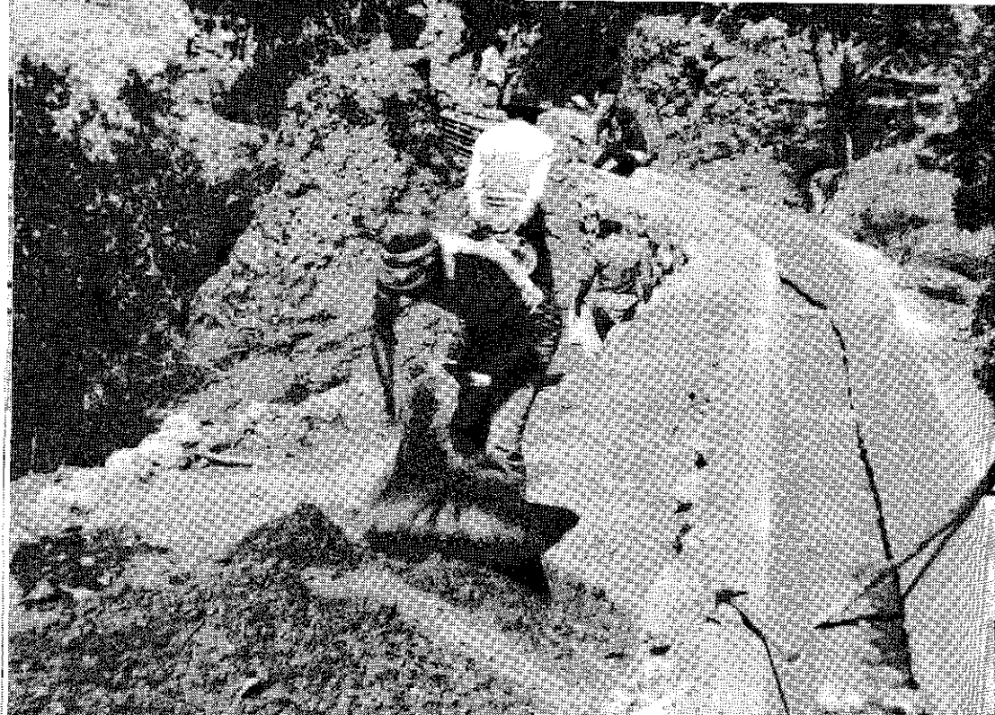
Revestimiento de canal de irrigación en beneficio del agro ayacuchano.
