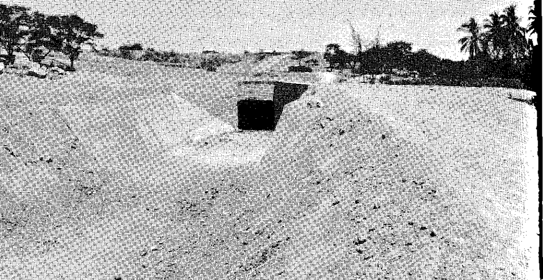
Obra de rehabilitación del canal "Miguel Checa" en Sullana.
