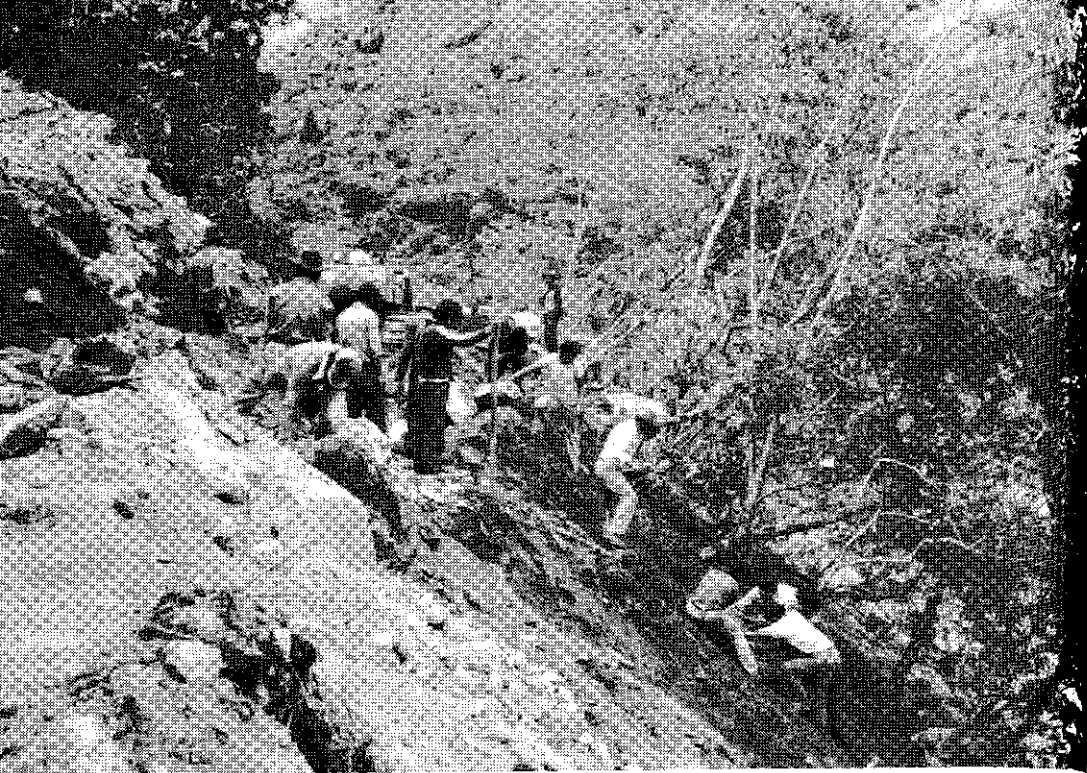
Construcción de la carretera Koribeni-Sangobatea-Santoato en la provincia de La Convención.
