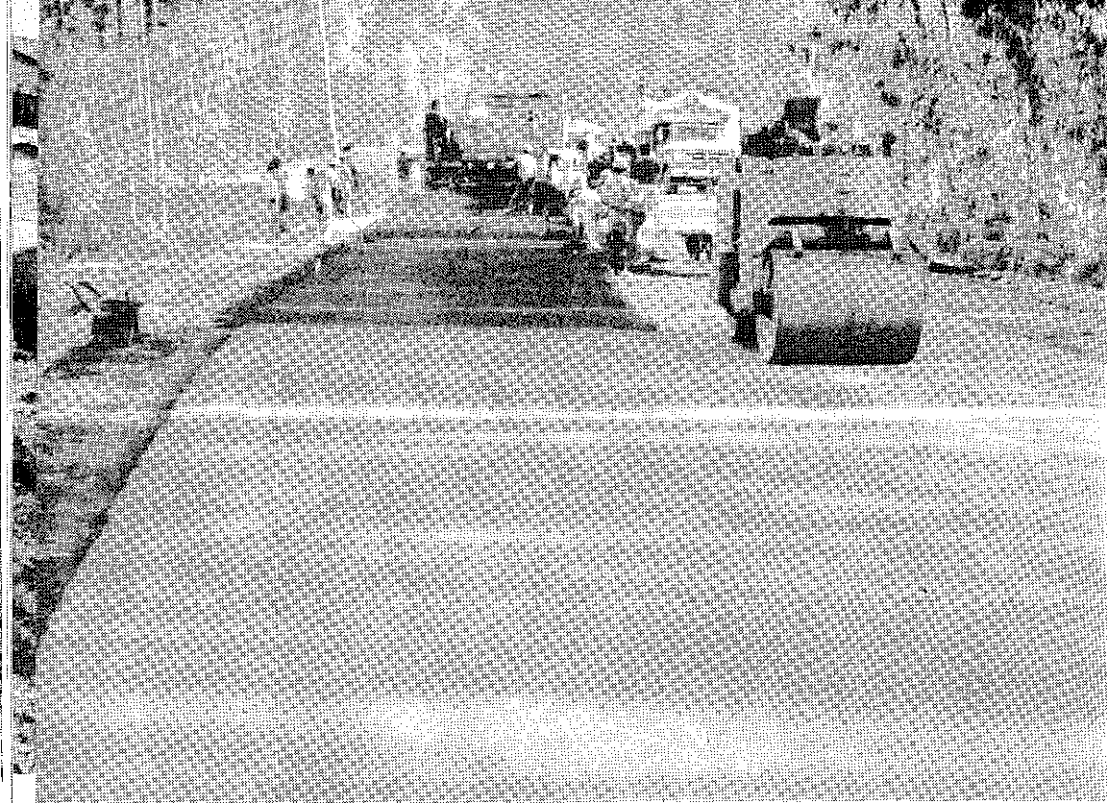
Trabajos de asfaltado de la carretera Huancayo-Huayucachi.
