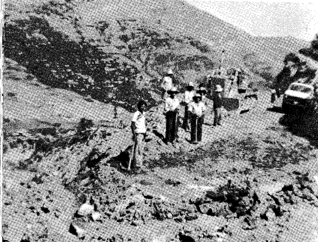
Vista de los trabajos de mejoramiento de la vía Ichocan-Shirac, Cajamarca.
