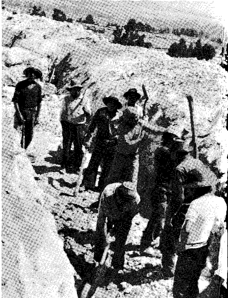
Construcción del canal de irrigación en San José de Apata, distrito de Apata.
