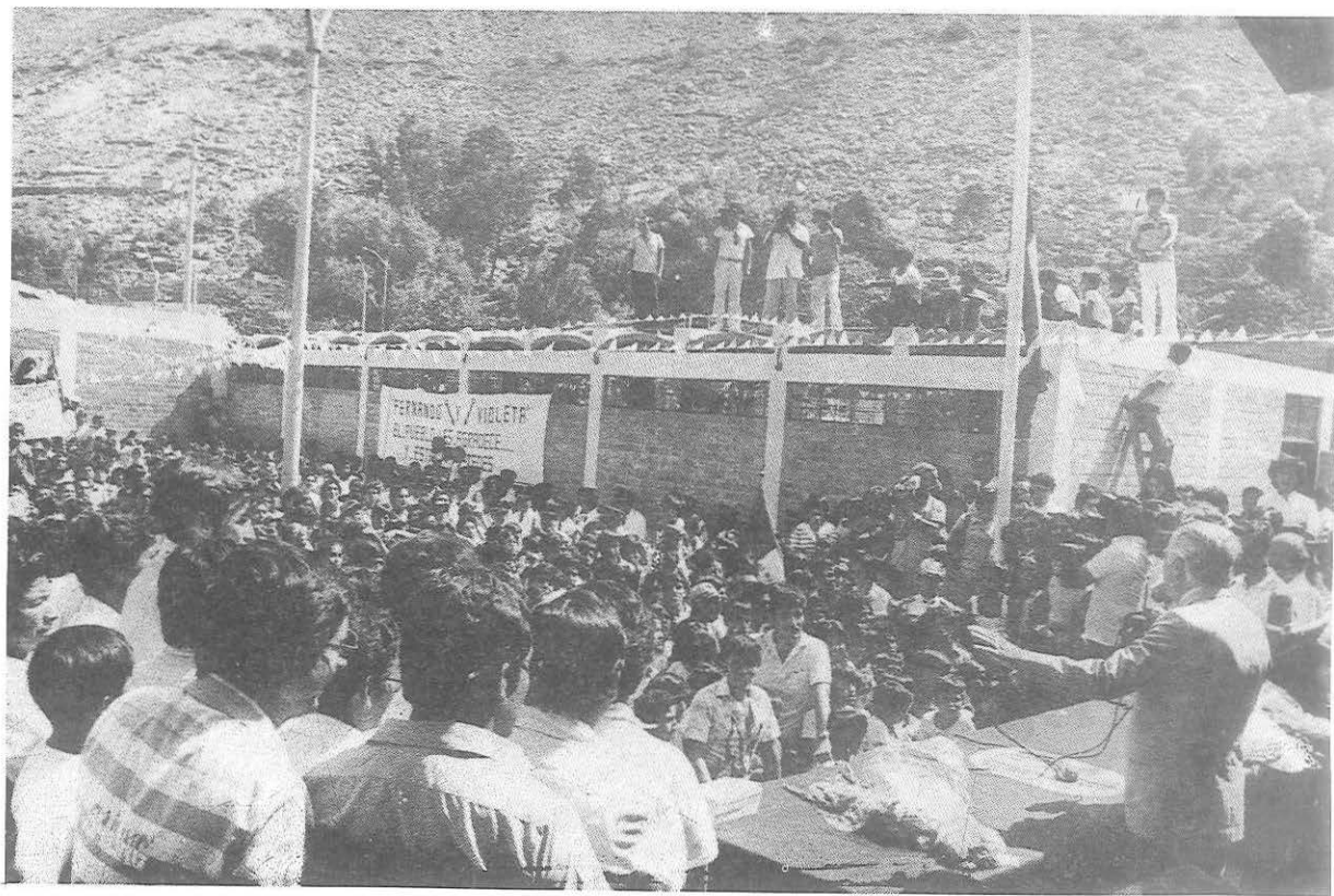
“San Antonio de Pedregal Alto” (Chosica) es otro pueblo joven que se beneficia con un amplio Centro Comunal construido y equipado por el Sistema de Cooperación Popular, con ayuda del pueblo laborioso que sólo busca un punto de apoyo para construir.
