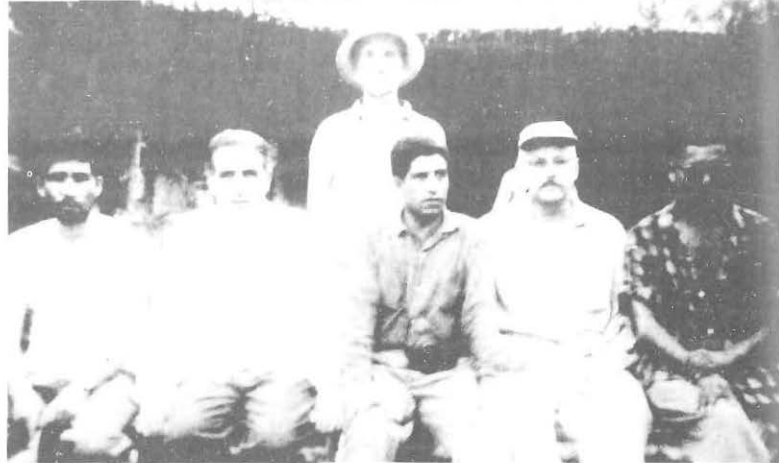
En el campamento del camino en construcción en Shanusi, entre Yurimaguas y Tarapoto.
