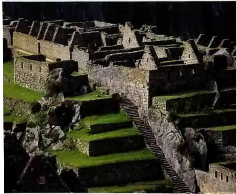
Machu Picchu, terrazas agrícolas. Perfectamente adaptadas a la topografía local, tenían canales de desagüe que aseguraban un dominio total del escurrimiento del agua.
